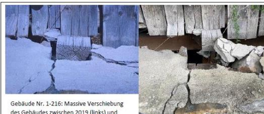
Gebäude Nr. 1-216: Massive Verschiebung des Gebäudes zwischen 2019 (links) und 2021 (rechts).
