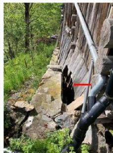
Gebäude Nr. 1-216: Der Holzerbau hat sich durch die Bewegungen vollständig von den Grundmauern gelöst (links: Ostseite=Talseite; unten Westseite = Bergseite). Das Gebäude ist einsturzfähig.
